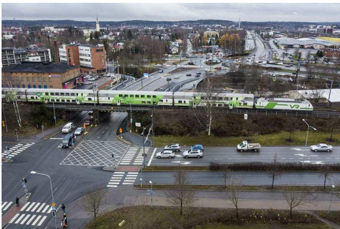
Kuva 1. Viinikankadun ja Ratapihankadun liittymä 11/2018, Kuva Aamulehti
